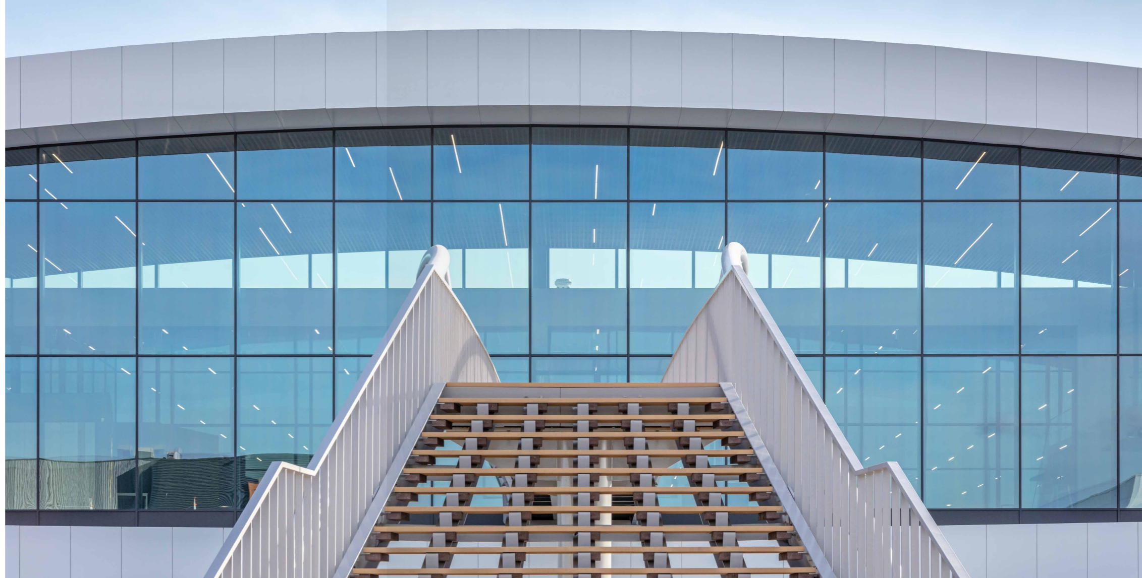
Centraal distributiecentrum LKQ Fource in Berkel en Rodenrijs. Bijnaam "The Bridge" verwijst naar de eyecatcher van dit spectaculaire ontwerp van Heembouw Architecten, de brug naar de centrale hal op de eerste verdieping.
